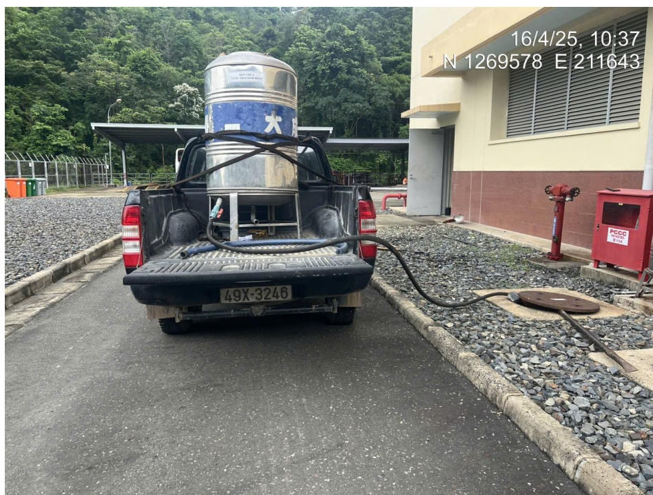
Hình 3. Hình ảnh bồn chứa vận chuyển nước thải từ khu vực Trạm phân phối, Đập tràn về cụm bể XLNTSH 05 gần khu Nhà máy
